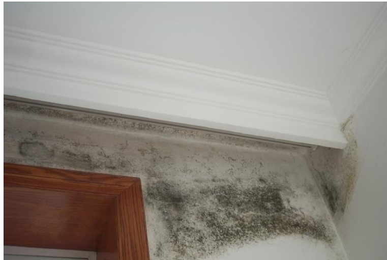
图 1 典型的长满霉菌的墙壁
